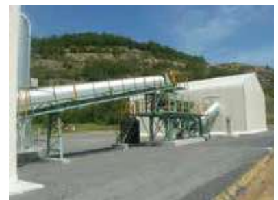
八戸バイオマスプラント
